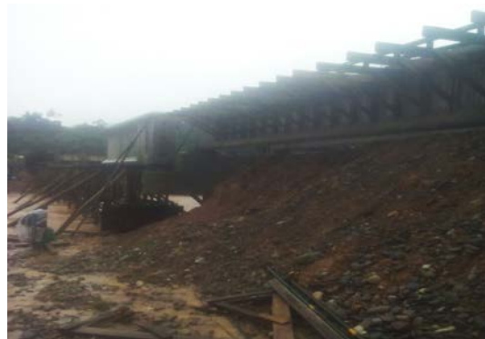
Plataforma del puente sobre el río Isiboro. Fuente: El Deber. Foto: Fernando Vargas, expresidente Subcentral TIPNIS, 2018.
