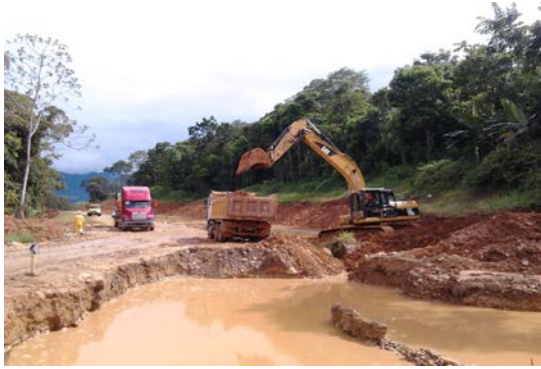
Obras durante la construcción del tramo. Fuente: Empresa Estratégica Boliviana de Construcción y Conservación de Infraestructura Civil.
