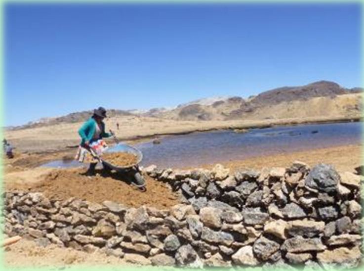
✧ LAGUNA MESACCOCHA – PROCESO CONSTRUCTIVO
