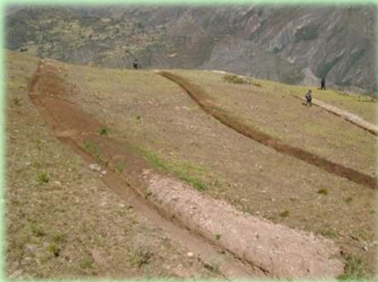
ZANJAS DE INFILTRACION
